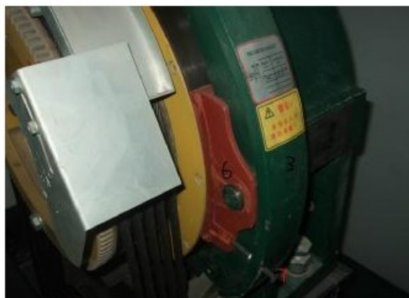
图（6）闸瓦位置实物照片图
